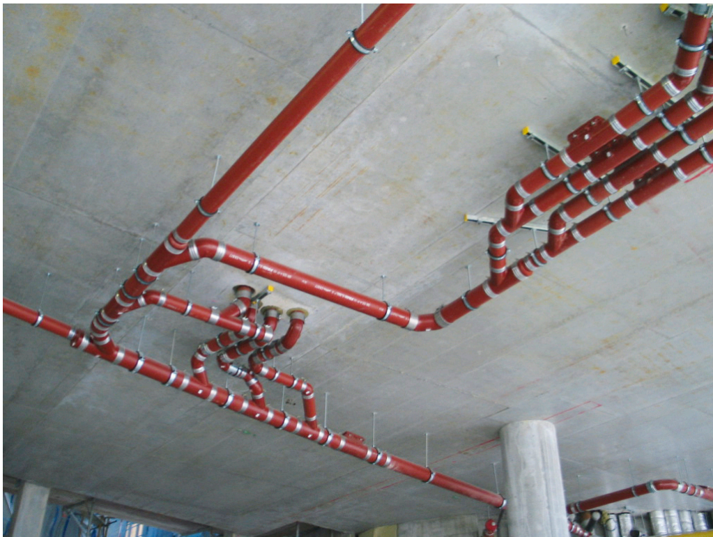
Foto „Nichtbrennbares gusseisernes Abflussrohrsystem PAM-GLOBAL S“ (SAINT-GOBAIN HES)
