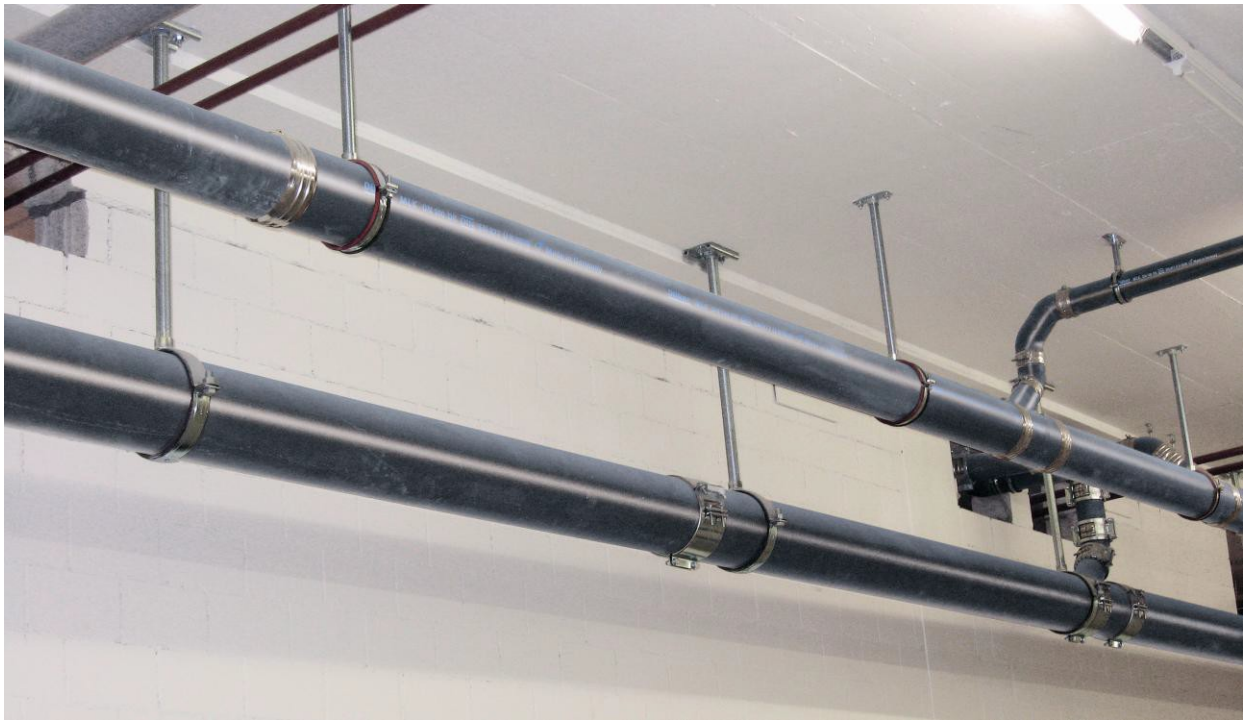
Foto: Nichtbrennbares gusseisernes Abflussrohrsystem mit Sonderbeschichtung Typ MLK-protect (Firma Düker)
