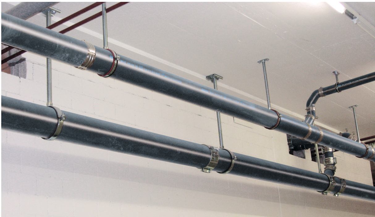
Foto „Nichtbrennbares gusseisernes Abflussrohrsystem mit Sonderbeschichtung Typ MLK-protec“ (Düker)
